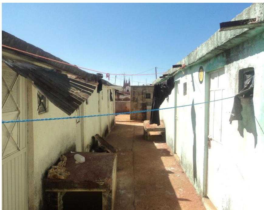
Distribución espacial de los cuartos en renta. La ubicación de esta sección es en la azotea del edificio. Arandas, Jalisco. Fotografía: RAHL (2012).
