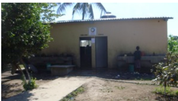
Fotografía 10. Baños y lavaderos, remodelados por SEDESOL.
